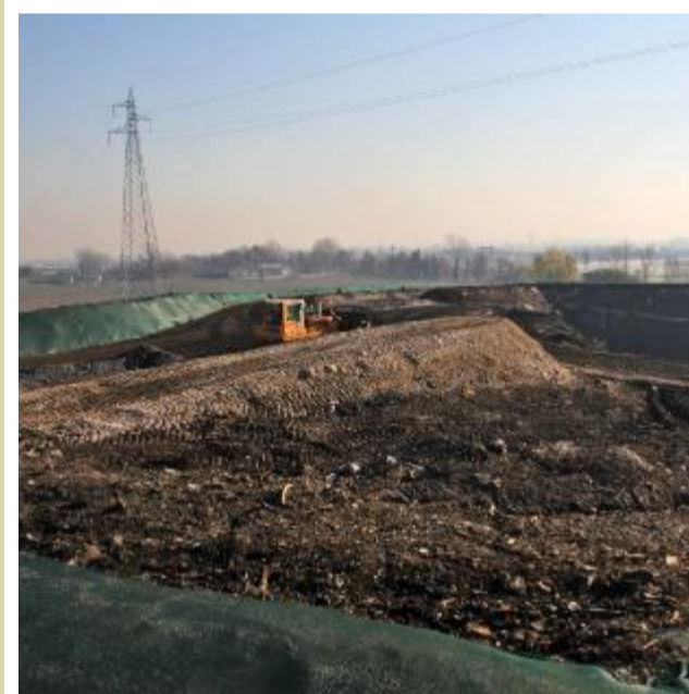
La parte dell'area interessata dal progetto del nuovo impianto
